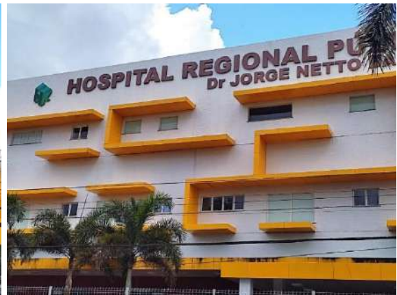
DEPOIS DA LIMPEZA
