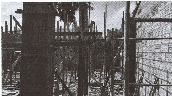
Imagens 06, 07 e 08: Estrutura do bloco B
