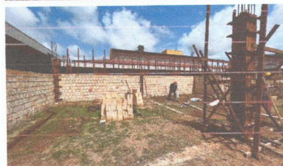
Imagens 10,11, 12 e 13: Alvenaria e concretagem dos pilares do bloco A
