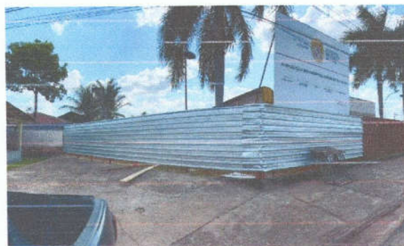
Imagens 01 e 02: Placa da obra e instalação de tapume na parte da frente da obra.
