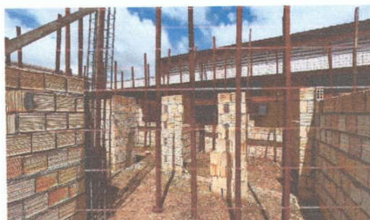
Imagens 14 e 15: Cimbramento para vigas e lajes da cobertura do bloco A
