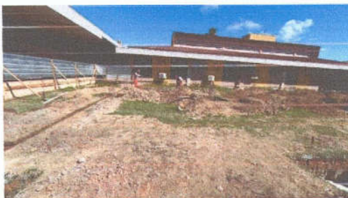
Imagens 08 e 09: Escavação e concretagem de sapatas e vigas de fundação do Bloco A
