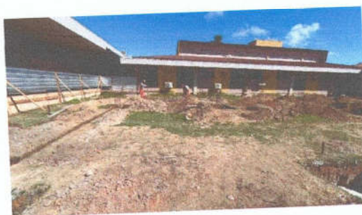
Imagens 08 e 09: Escavação e concretagem de sapatas e vigas de fundação do Bloco A
