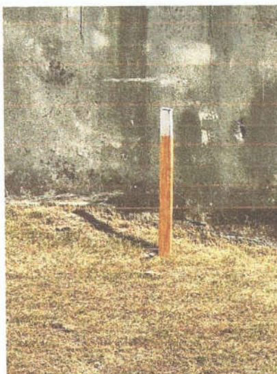
Imagem 07: Piquete de marcação do terreno dos blocos A e B.
