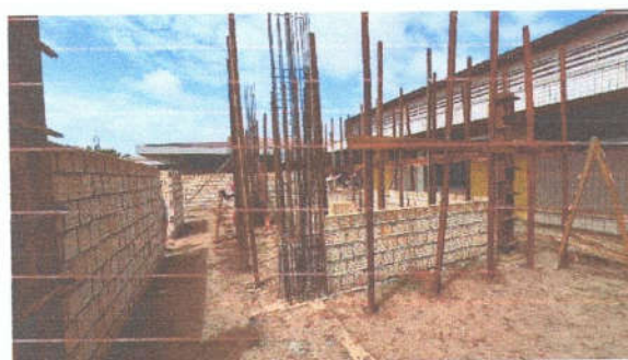
Imagens 14 e 15: Cimbramento para vigas e lajes da cobertura do bloco A
