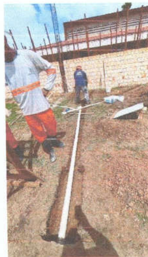
Imagens 16 e 17: Tubulações de esgoto do Bloco A.
