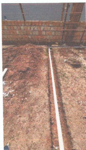
Imagens 16 e 17: Tubulações de esgoto do Bloco A.
