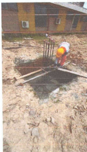
Imagem 07: Piquete de marcação do terreno dos blocos A e B.
