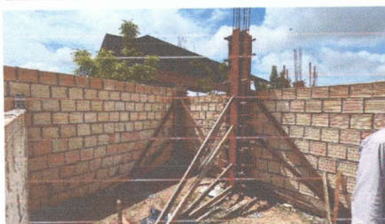
Imagens 10,11, 12 e 13: Alvenaria e concretagem dos pilares do bloco A
